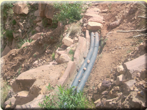
\Omega Canal de transporte o Aducción
