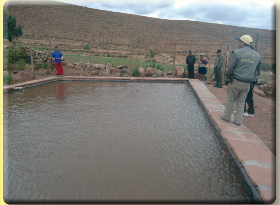
\Omega Protección de coronamiento
