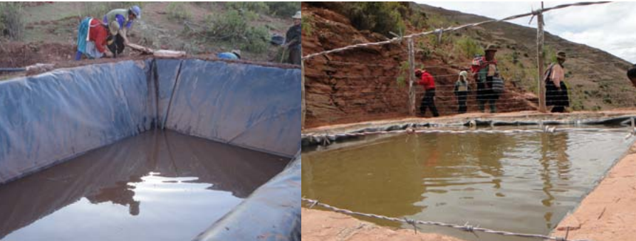
Foto: Muestra de reservorio de SCAF en construcción (izquierda) y otro ya concluido (derecha) con geomembrana.
