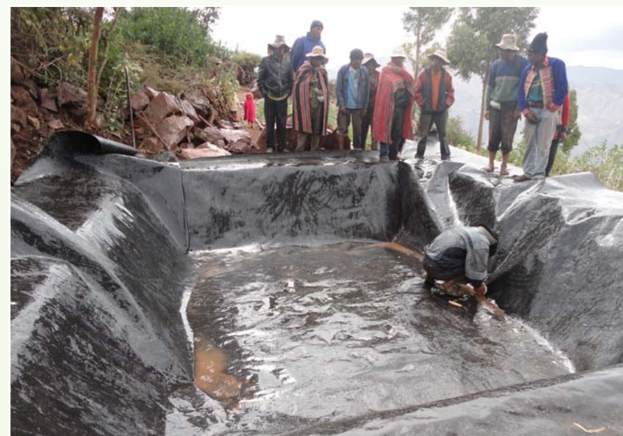
Foto: Grupo familiar participa con mano de obra en la construcción del sistema de cosecha de agua.
